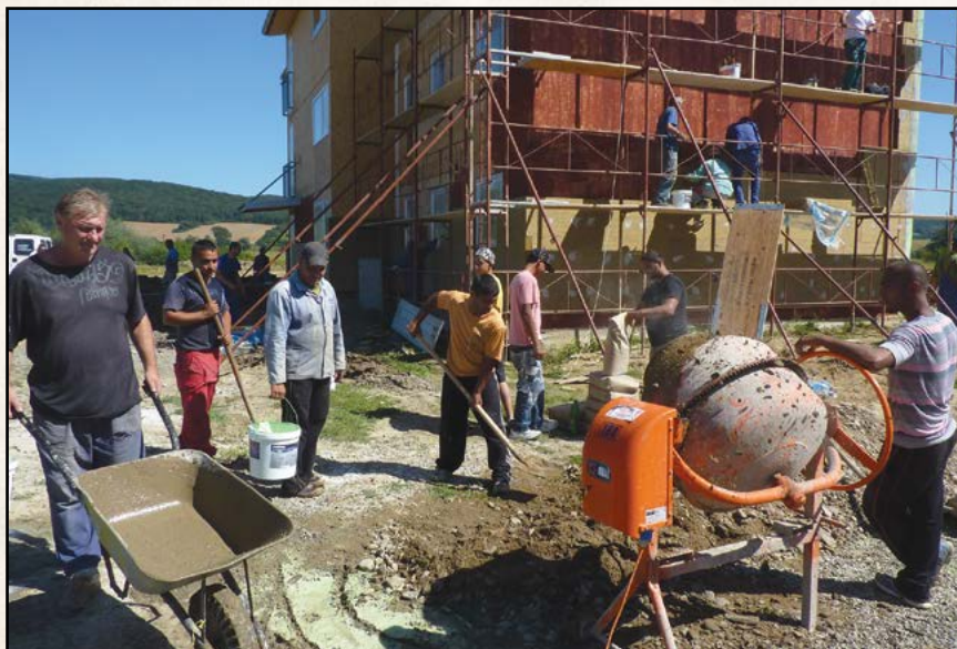
Bytovka – výstavba II. 9 b.j.
