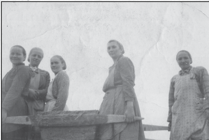
Výstavba obce zničenej po vojne Mražiková, Paľušová, Gavurová
