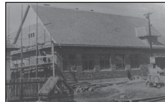
Práce na výstavbe novej Národnej školy v Malej Domaši
